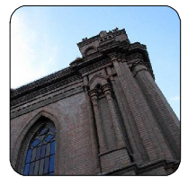
Casco Hospital San Juan de Dios, San Fernando
